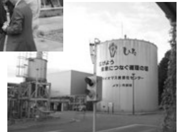
▶バイオマス発電施設 (日田市)
