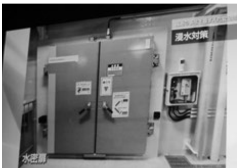
▲原子炉建屋の浸水対策
