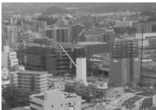
▶大分市中心市街地の一角をなす大分駅ビルの工事
