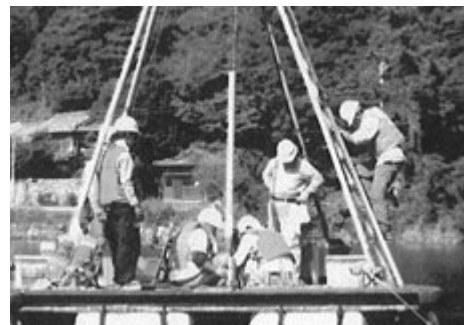
▲ボーリング調査の様子
