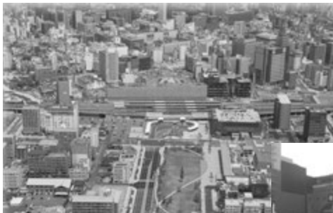
▲高架が完成した大分駅
