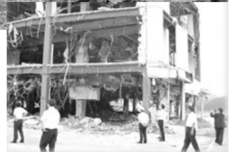
▲ 3.11 被災後間もない頃の状況
