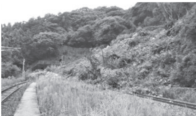
▲土砂崩れで片側が埋まった日豊本線津久見市徳浦信号所
