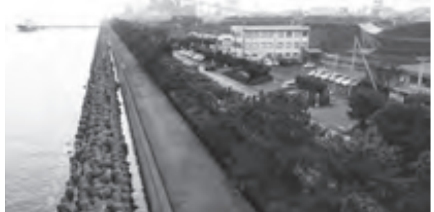
▲大分港海岸の津留地区の現況
