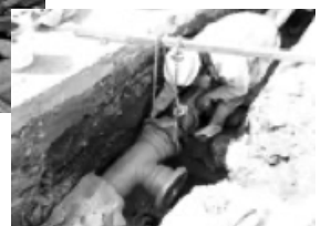
◀▼大分市内で施工されている水道管の耐震化工事の模様
