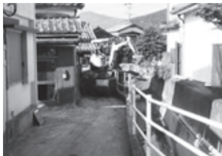
▲ 2016年9月に台風16号で集落に 流入した砂利を撤去する作業
