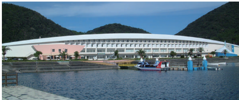
▲マリナルチャーセンター（解体）
